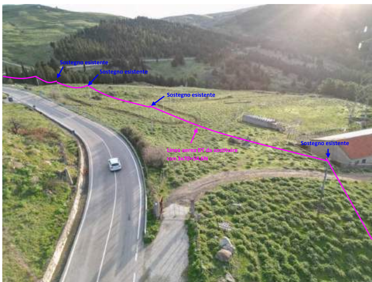
Foto 3 – Foto con vista dei luoghi con linea aerea BT da sostituire e sostegni esistenti.
