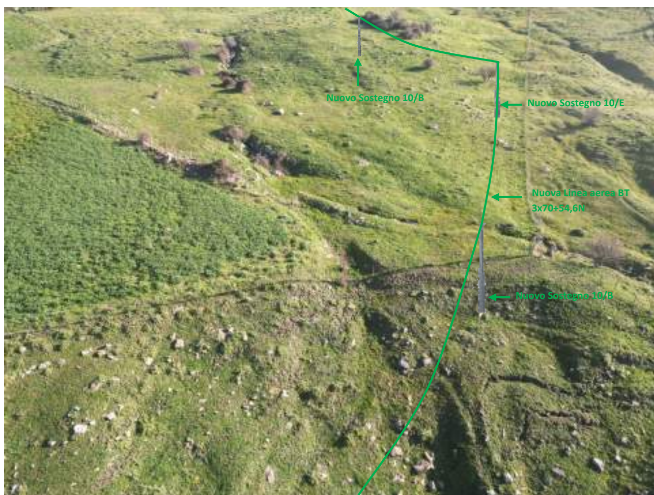
Foto 10 – Foto con vista dei luoghi con nuova linea aerea BT e nuovi sostegni.
