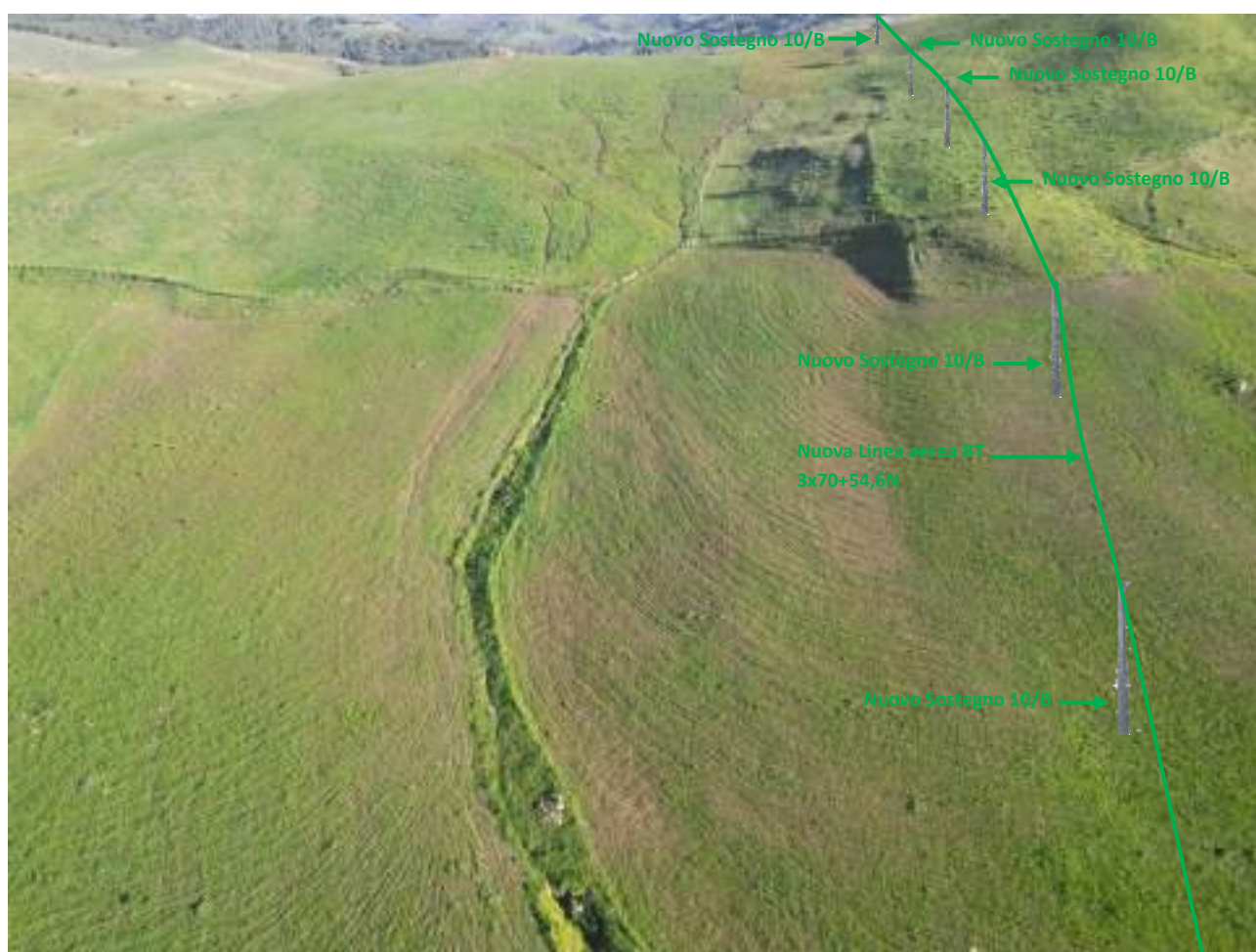
Foto 14 – Foto con vista dei luoghi con nuova linea aerea BT e nuovi sostegni.
