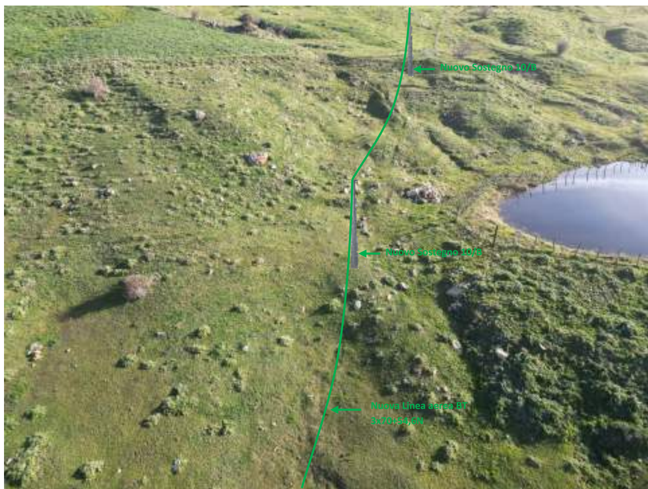
Foto 9 – Foto con vista dei luoghi con nuova linea aerea BT e nuovi sostegni.
