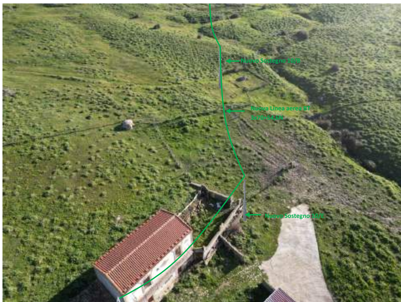
Foto 7 – Foto con vista dei luoghi con nuova linea aerea BT e nuovi sostegni.
