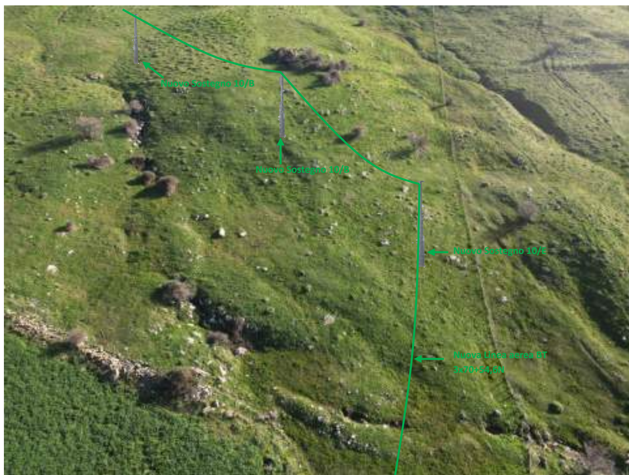
Foto 11 – Foto con vista dei luoghi con nuova linea aerea BT e nuovi sostegni.
