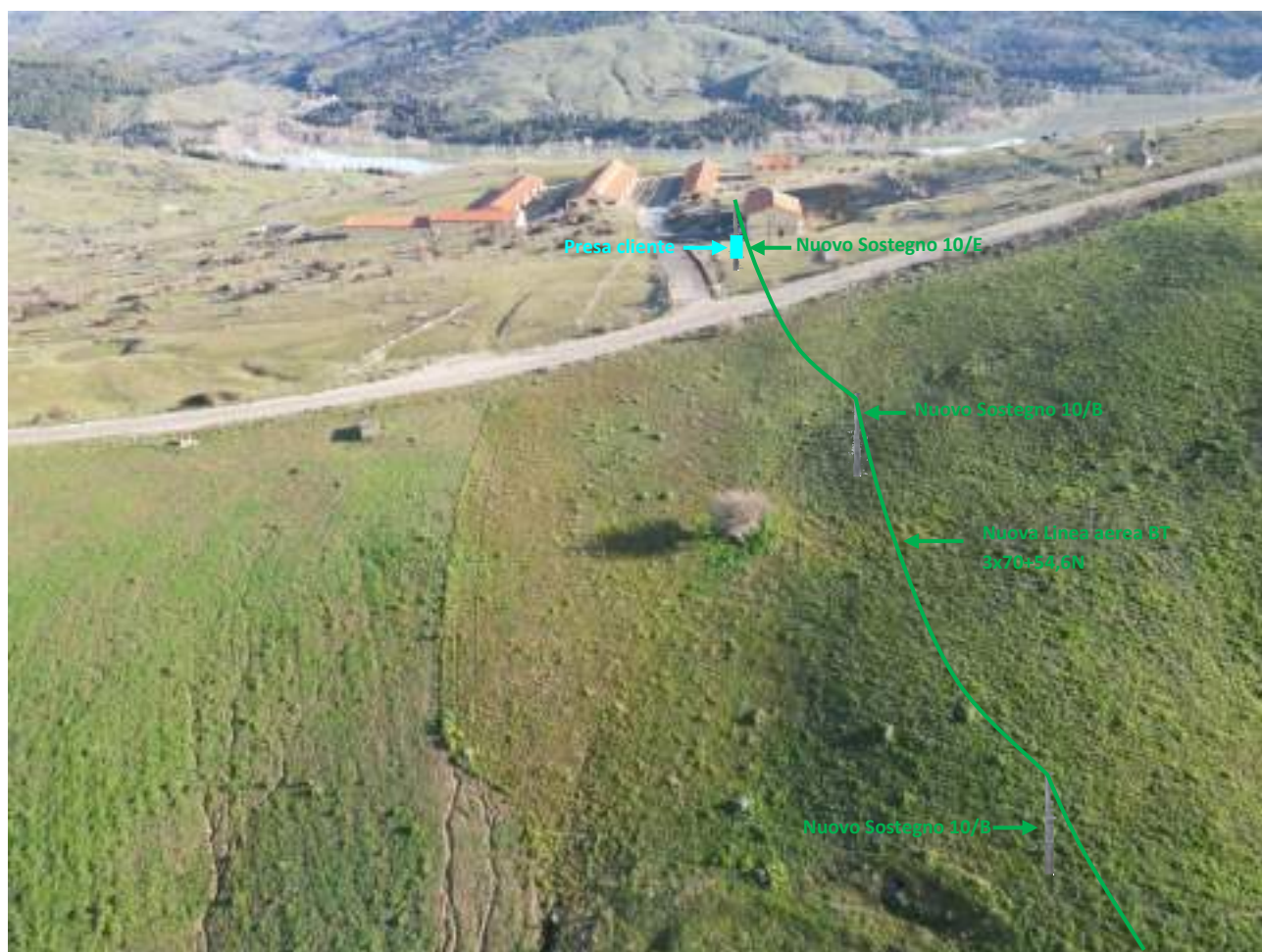
Foto 16 – Foto con vista dei luoghi con nuova linea aerea BT e nuovi sostegni.
