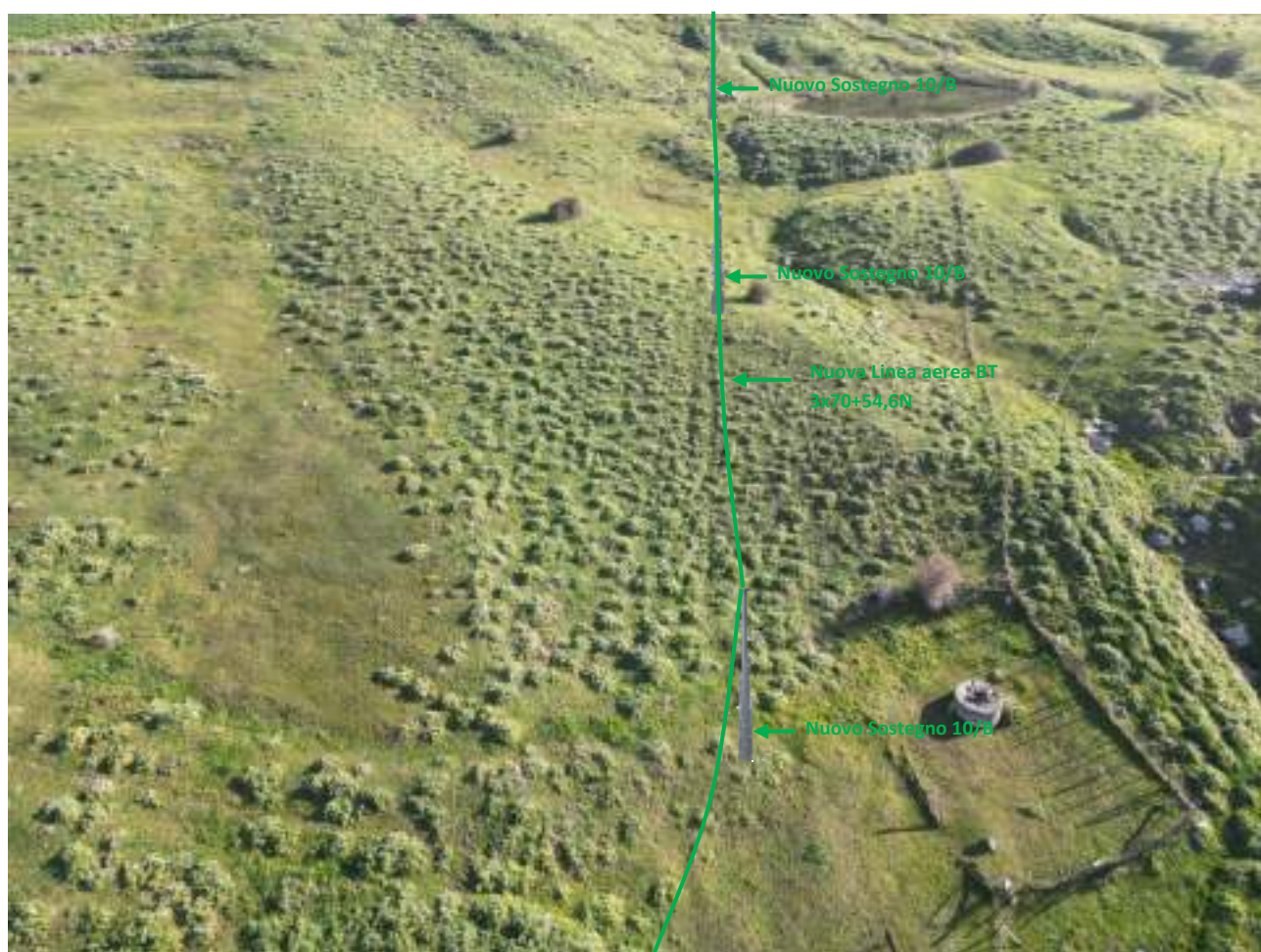
Foto 8 – Foto con vista dei luoghi con nuova linea aerea BT e nuovi sostegni.
