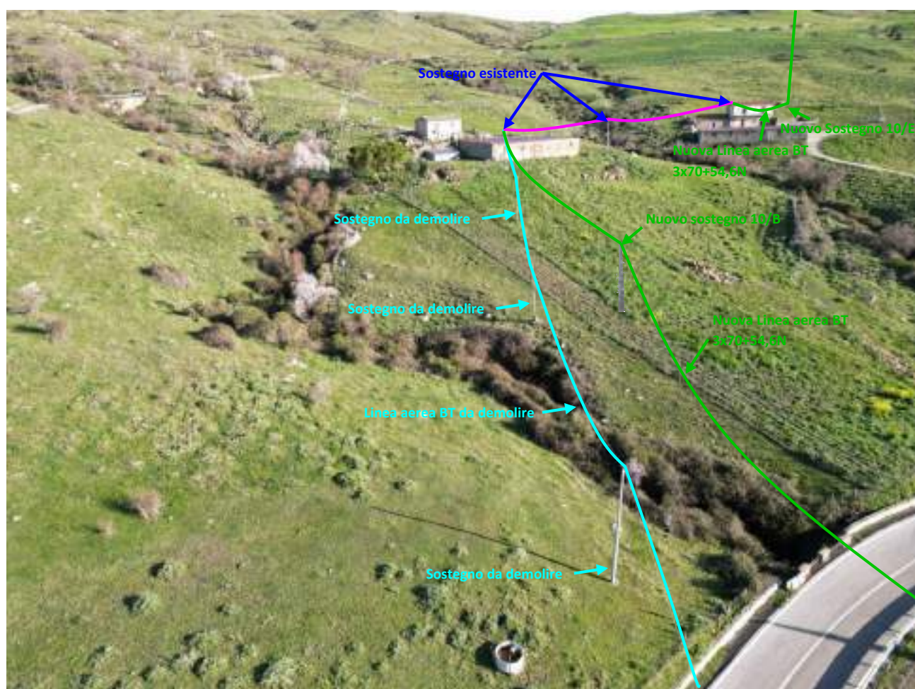
Foto 5 – Foto con vista dei luoghi con linea aerea BT da sostituire, demolire e nuova linea aerea BT da realizzare.
