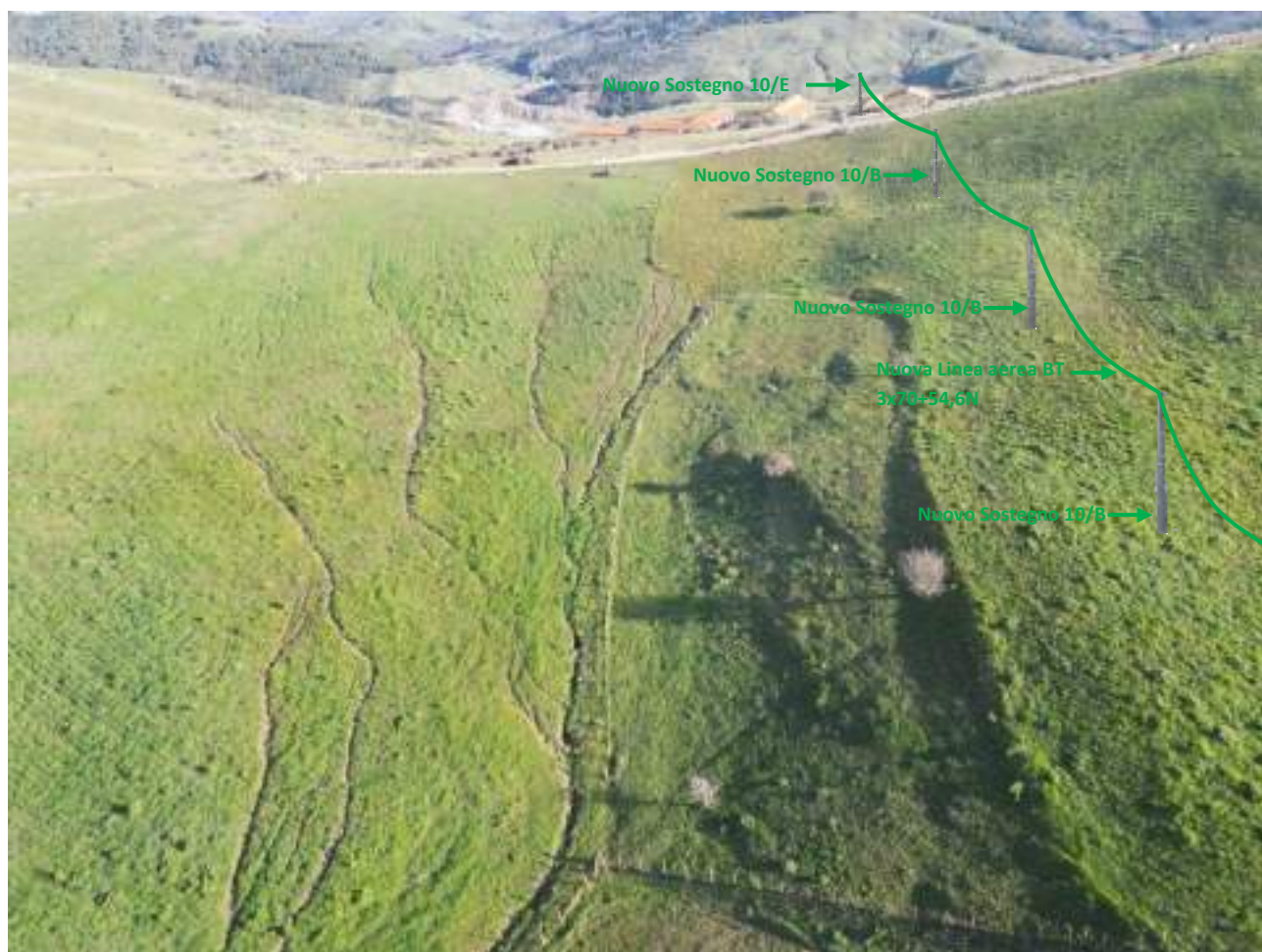
Foto 15 – Foto con vista dei luoghi con nuova linea aerea BT e nuovi sostegni.
