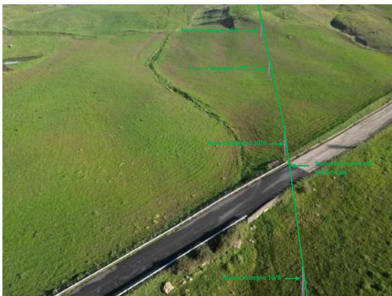
Foto 13 – Foto con vista dei luoghi con nuova linea aerea BT e nuovi sostegni.
