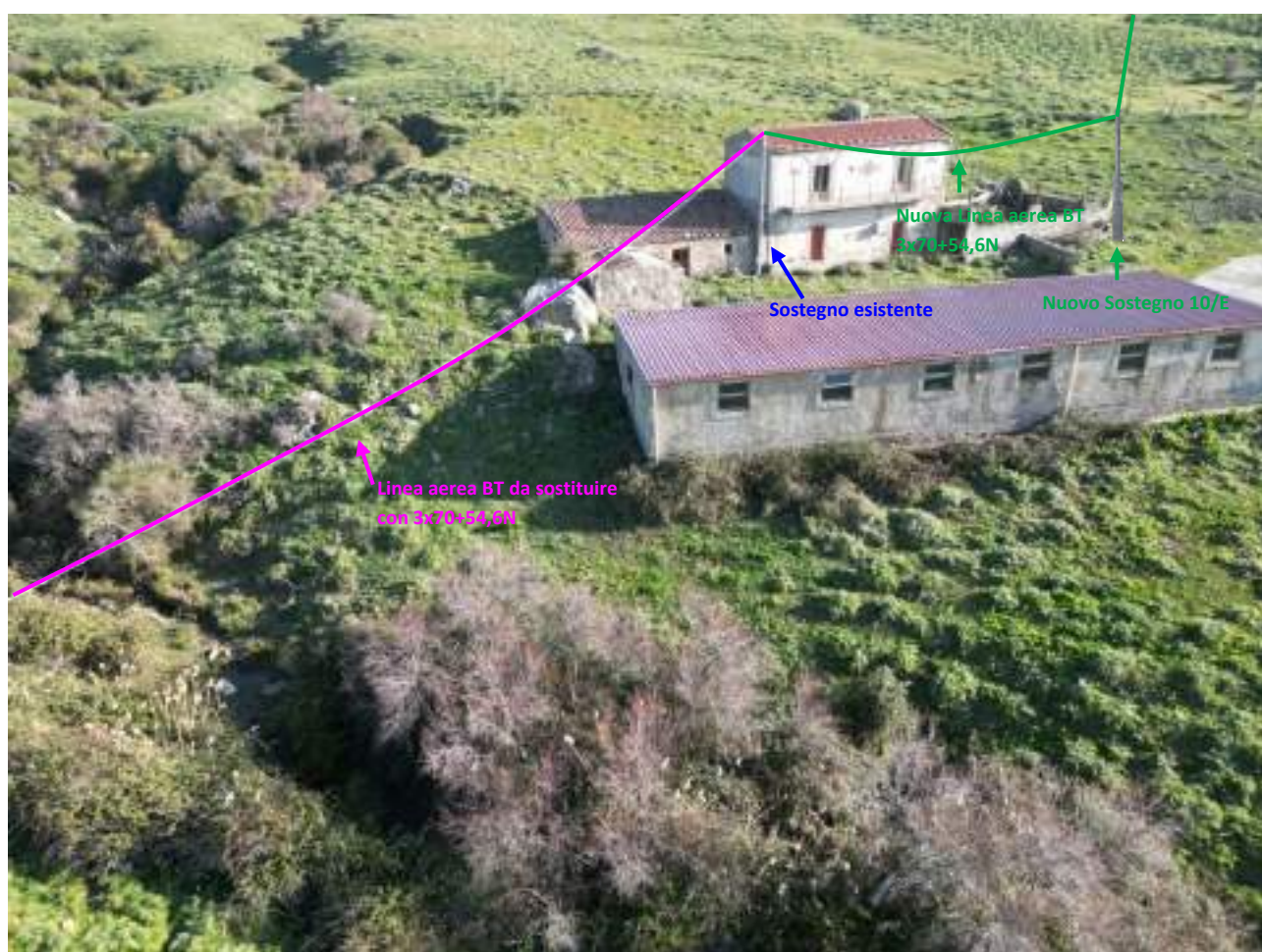
Foto 6 – Foto con vista dei luoghi con linea aerea BT da sostituire, sostegni esistenti, nuova linea aerea BT e nuovi sostegni.
